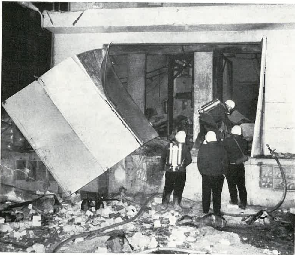
Die Feuerwehr im Einsatz: Männer bei Aufräumarbeiten in der Absackanlage auf der Ostseite des Maschinenhauses. Herausgerissene Türen und herumliegende Steinbrocken kennzeichnen die Wucht der Explosion.
