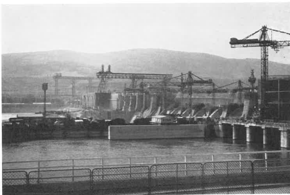
Das Ziel der Reise: Baustelle „Eisernes Tor“.
