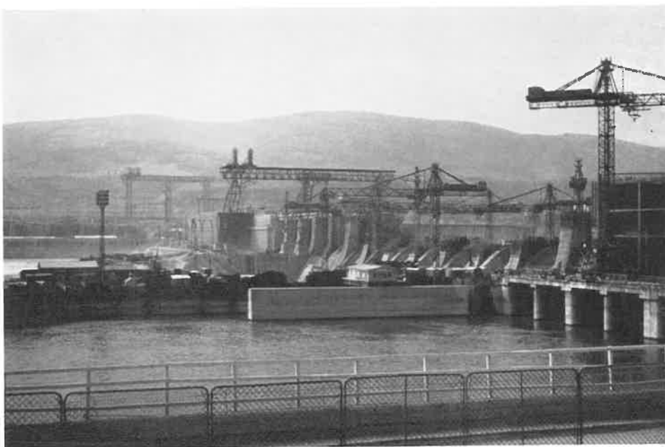
Das Ziel der Reise: Baustelle „Eisernes Tor“.
